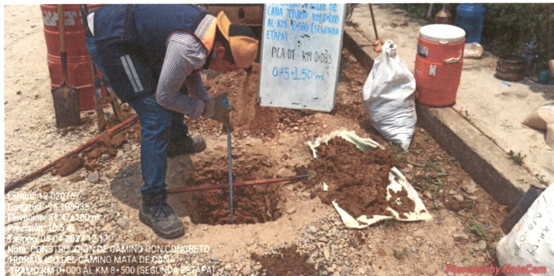
Figura 4 Pozo a Cielo Abierto (PCA-01)
