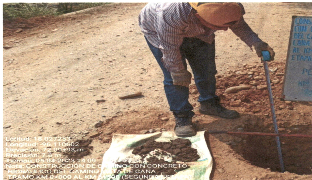
Figura 5 Pozo a Cielo Abierto (PCA-02)
