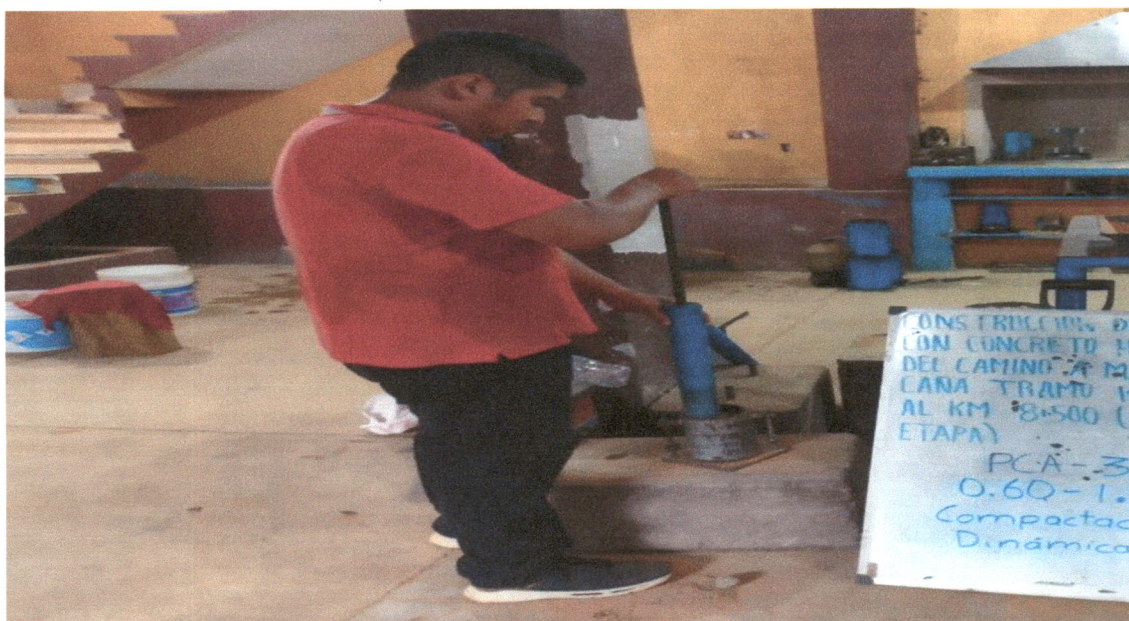
Figura 10 Grado de compactación
