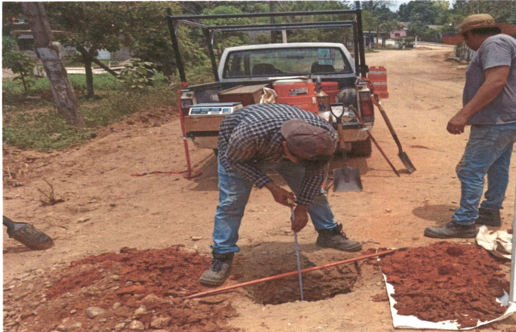
Figura 6 Pozo a Cielo Abierto (PCA-03)
