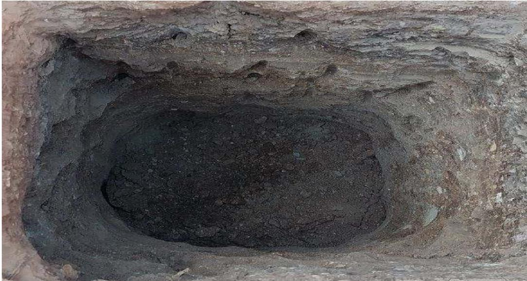
Figura 5.7.6. Pozo a Cielo Abierto PCA-03 carril único lado derecho
